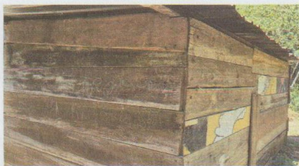
Foto 2: Esta Aula se desarmo para hacer la construcción del aula tipo portico.
