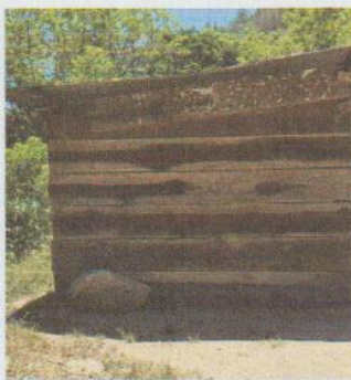
Foto 3: Fotografía del Aula de madera de la parte de atrás.
